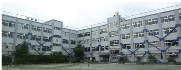
写真 1 補強建物外観
