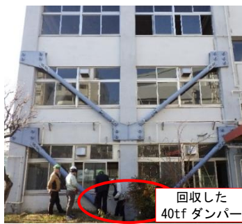
写真 1 解体対象の制震ブレース
