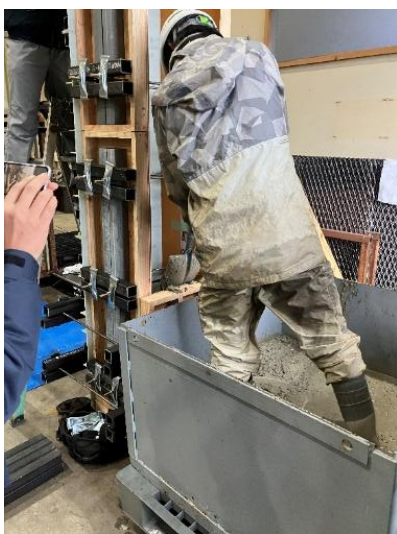
写真3 コンクリート打込み状況
