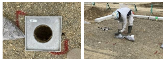
(左: 掘削状況、右: 砂の投入状況)
