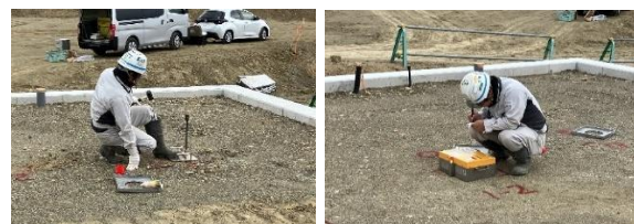
(左: 削孔状況、右: RI計器設置状況)
