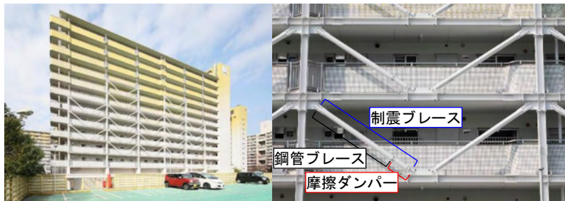
(a) 建物全景 (b) 制震ブレース 写真1 制震ブレース工法適用事例
