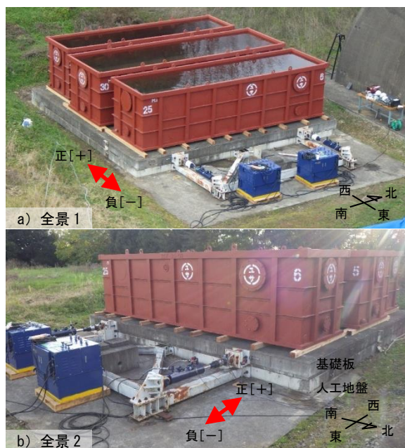
写真5 暴露10年後の実大滑り基礎の加力実験
