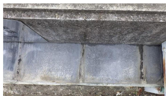
写真6 滑り面の状態(10年後)
