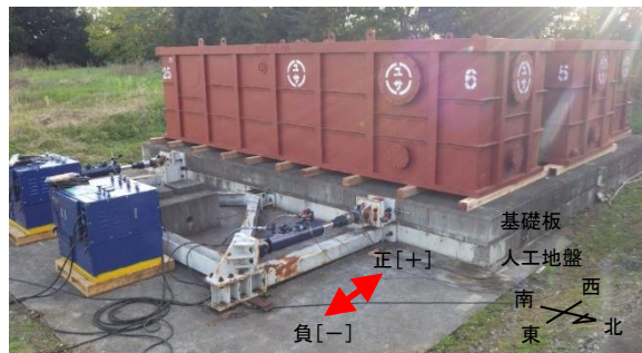
写真1 暴露10年後の実大滑り基礎の加力実験
