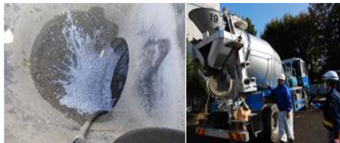
写真2 撥水剤添加状況
