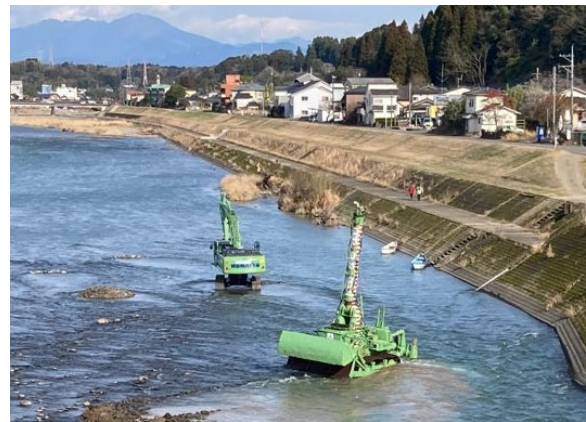
水陸両用ブルドーザ 水陸両用バックホウの施工状況
