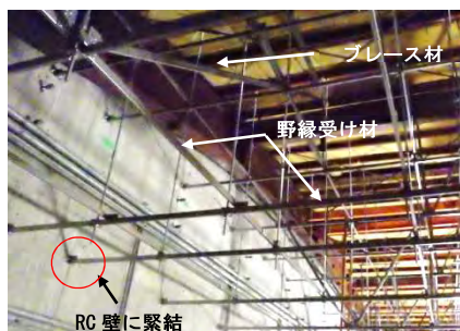
構造部材施工完了時
