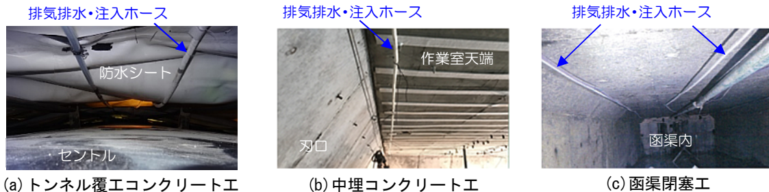
写真1 排気排水・注入ホースの設置状況
