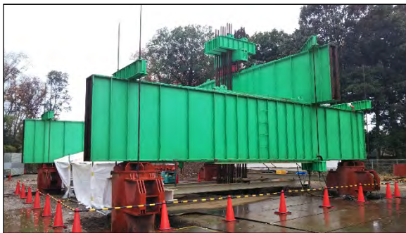
写真1 鉛直引抜き載荷実験状況
