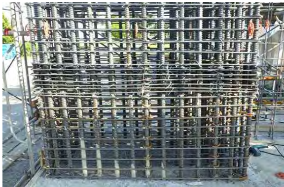
写真1 高強度柱試験体配筋状況
