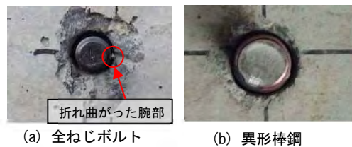
写真2 アンカー筋挿入後の状況
