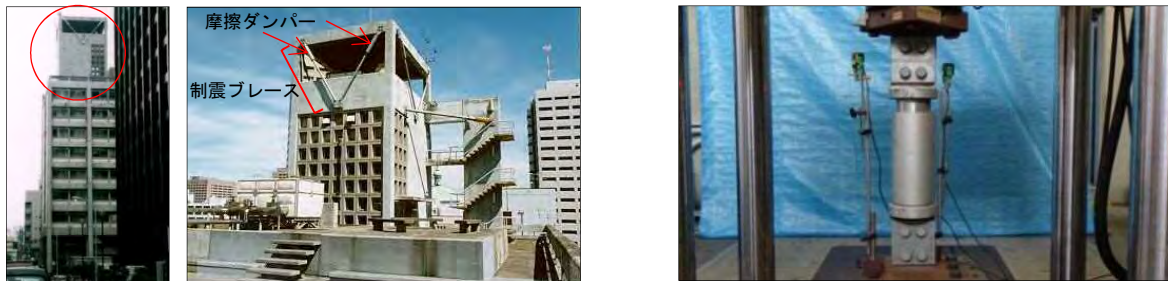
写真1 補強建物の外観
