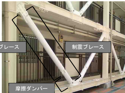
写真2 制震ブレースの概要
