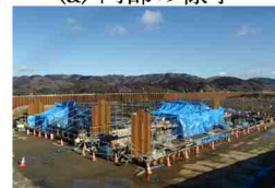
(b) 養生全景
