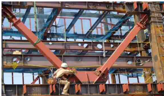
写真1 折返しブレースの建方状況
