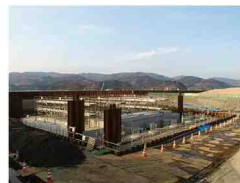
(a) 底版本体完成時
