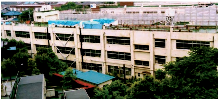
写真2 実験が行われた校舎の全景と実験状況
