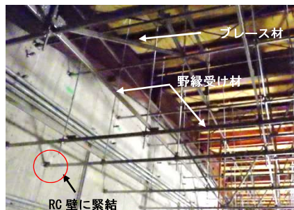
構造部材施工完了時
