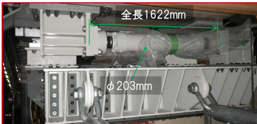
(b) 設置完了の詳細
