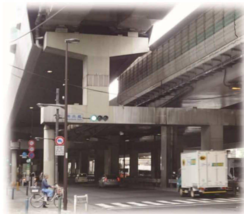
既設橋梁 (補強前)
