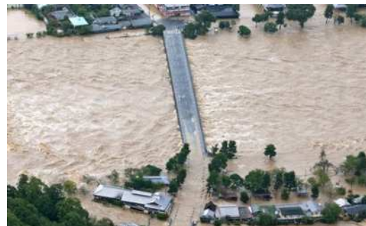
冠水被害の事例 (渡月橋_2013年台風18号)
