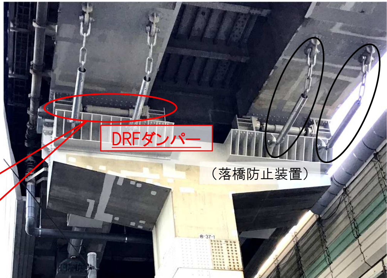
(c) 設置完了の全景
