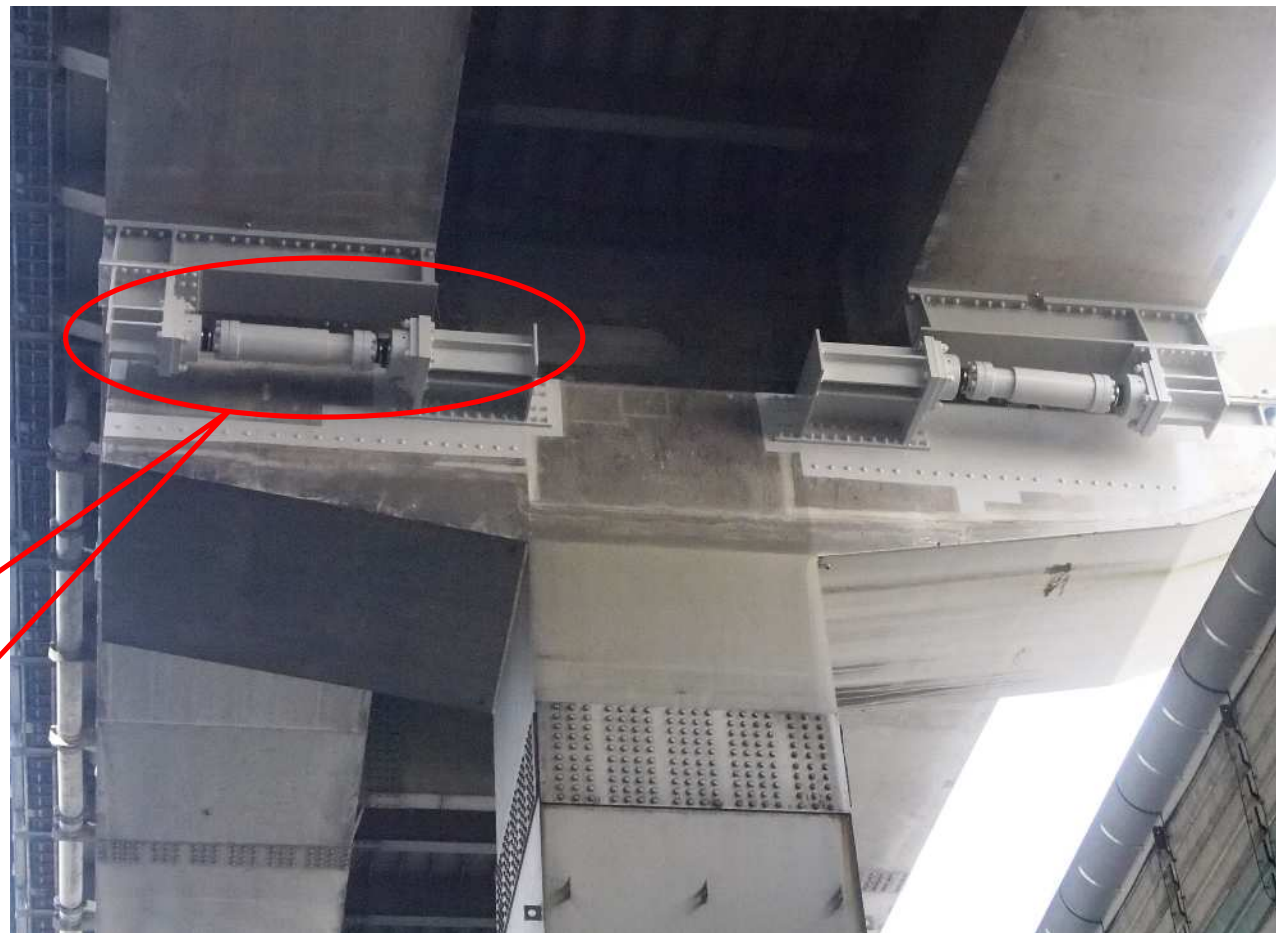
(c) 設置完了の全景
