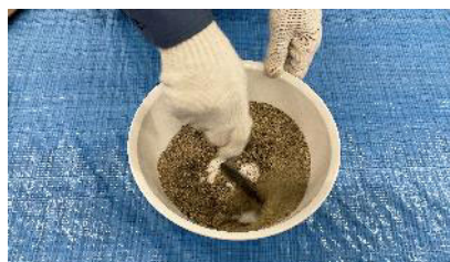
写真4 材料混合状況
