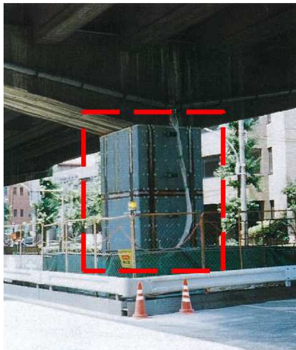
コンクリート橋脚へ鋼板巻き立て
