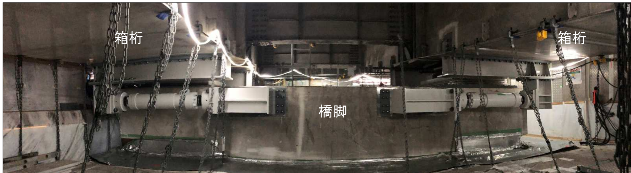
(a) 設置完了の全景
