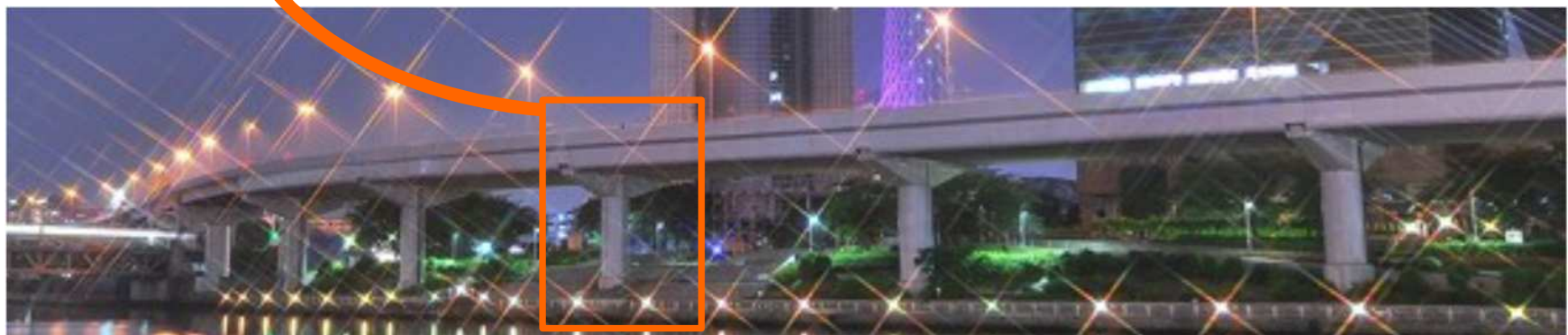
首都高速6号向島線 (RC造単柱橋脚)
