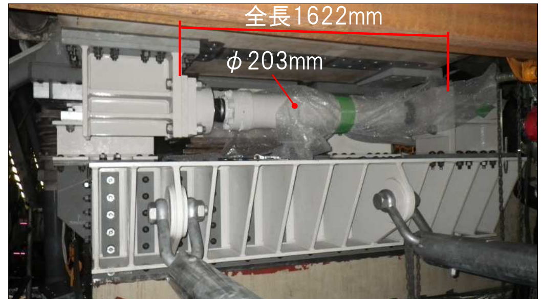
(e) 設置完了の詳細
