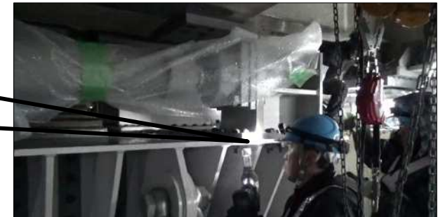
(c) ボルト締め状況
