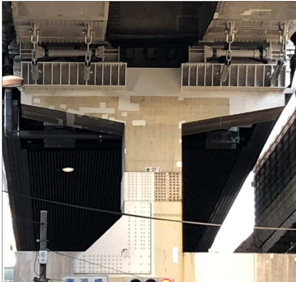
(d) 設置完了の全景
