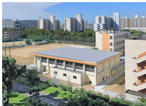
南港北中学校増築その他工事
