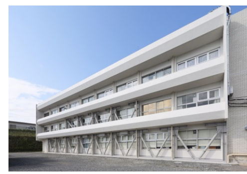
酒々井町役場中央庁舎耐震補強等改修工事
