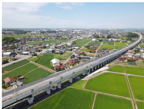
北陸新幹線 小松粟津高架橋
