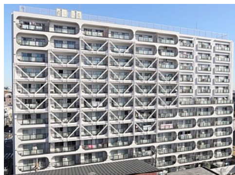
写真2 補強建物外観(西面)
