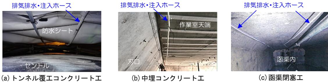
写真1 排気排水・注入ホースの設置状況
