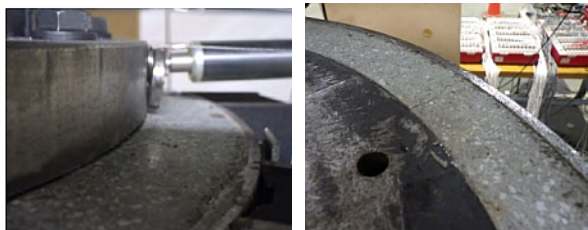
a) B-1 b) B-2 写真1 加力後の接合部天端の状況
