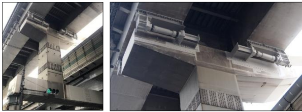
(a) 補強後全景(台-41) (b) 補強部拡大(台-41)
