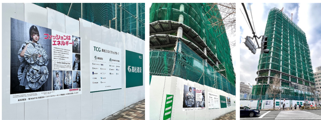
（仮称）TCG ビル新築工事現場の仮囲いに掲出された「スマイルウォーキング倶楽部」パネル
