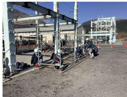
足場の組立実習
