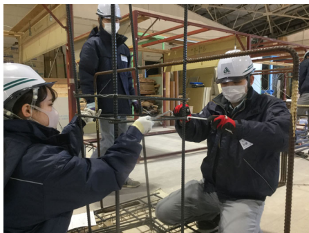
基礎配筋の組立実習
