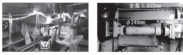
(d) 設置作業状況 (e) 設置完了状況（詳細）
