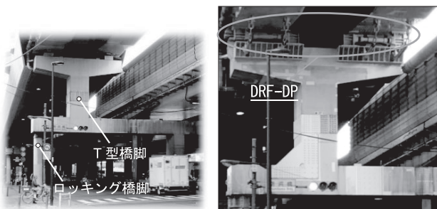
写真-3 本装置設置前後の外観(650 kN-200 mm タイプ)
