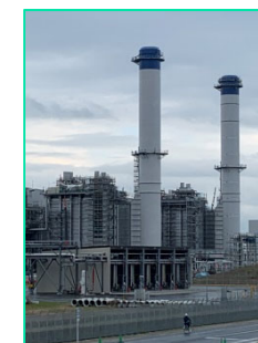
JAPEX相馬煙突据付・ 煙突耐火工事 （保温・耐火工事）
