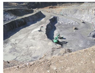
小石原川ダム工事 （爆砕工事）
