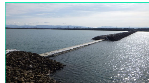
新潟港航路泊地付帯施設中仕切堤工事
