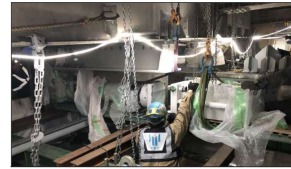
(b) 設置作業状況
