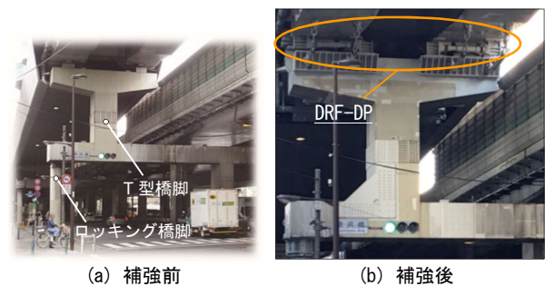
写真 3 DRF-DP 設置前後の外観
