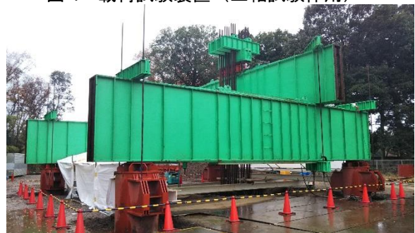
写真1 荷重試験装置全体
