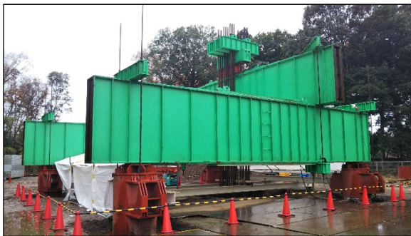
写真1 鉛直引抜き載荷実験状況
