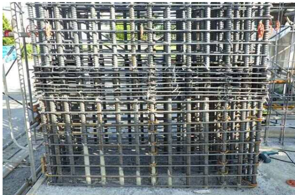
写真1 高強度柱試験体配筋状況
