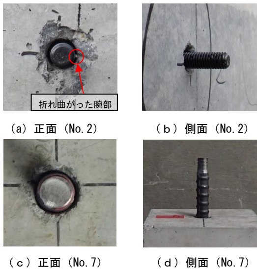
写真 8 アンカー筋挿入後の状況
