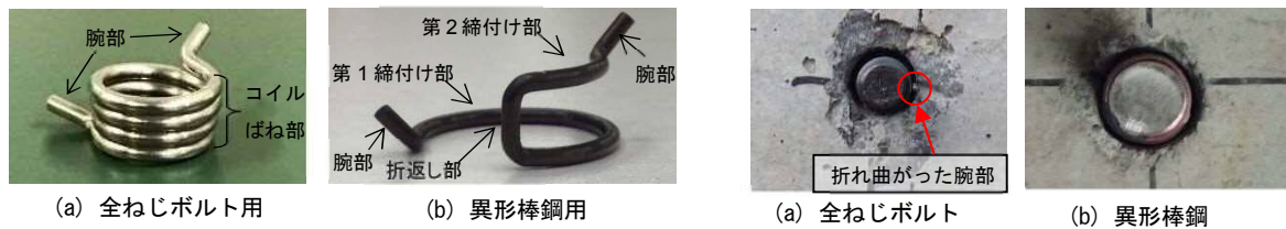
写真2 アンカー筋挿入後の状況
