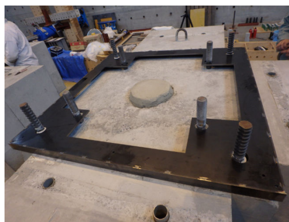
写真 1 鋼製型枠設置状況
