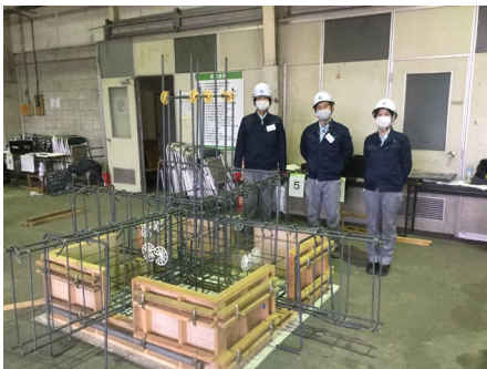
基礎配筋の組立実習
