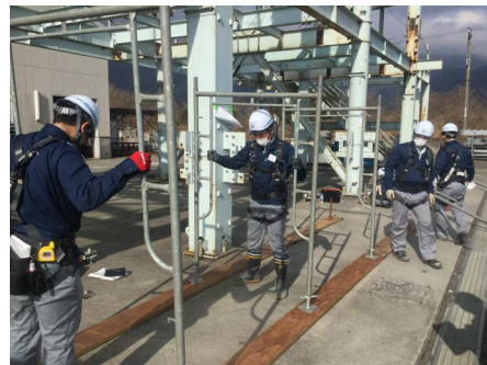
足場の組立実習
