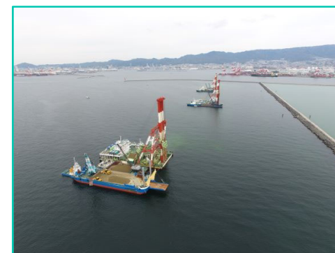
神戸港航路付帯施設地盤改良工事
