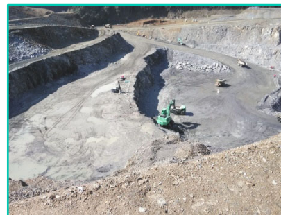
小石原川ダム工事 （爆砕工事）
