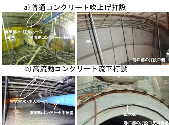
写真 4 設計巻厚 1500mm 呑口部の打設状況
