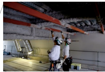
写真1 吊り材長さの確認
