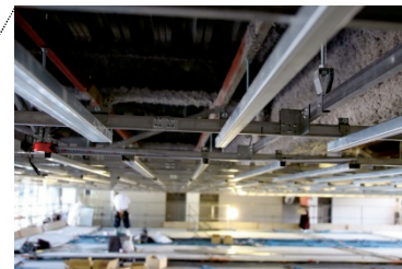
写真4 自主検査状況（野縁間隔）
