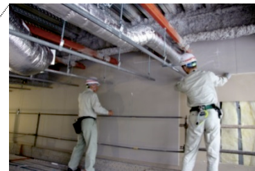
写真2 野縁受け取付け
