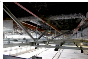
写真5 自主検査状況 （ブレース補強設置）
