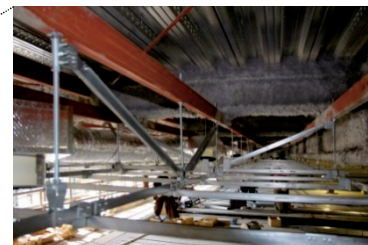
写真3 ブレース取付け
