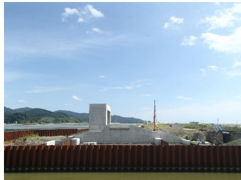
(b) 竣工時の水門の全景
