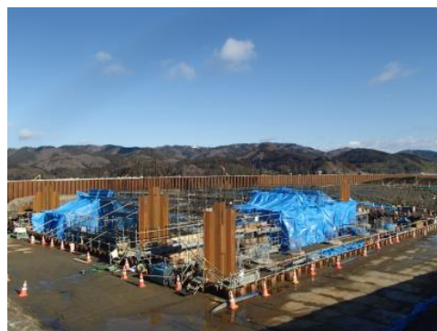
(b) 養生全景 写真 1 養生の様子
