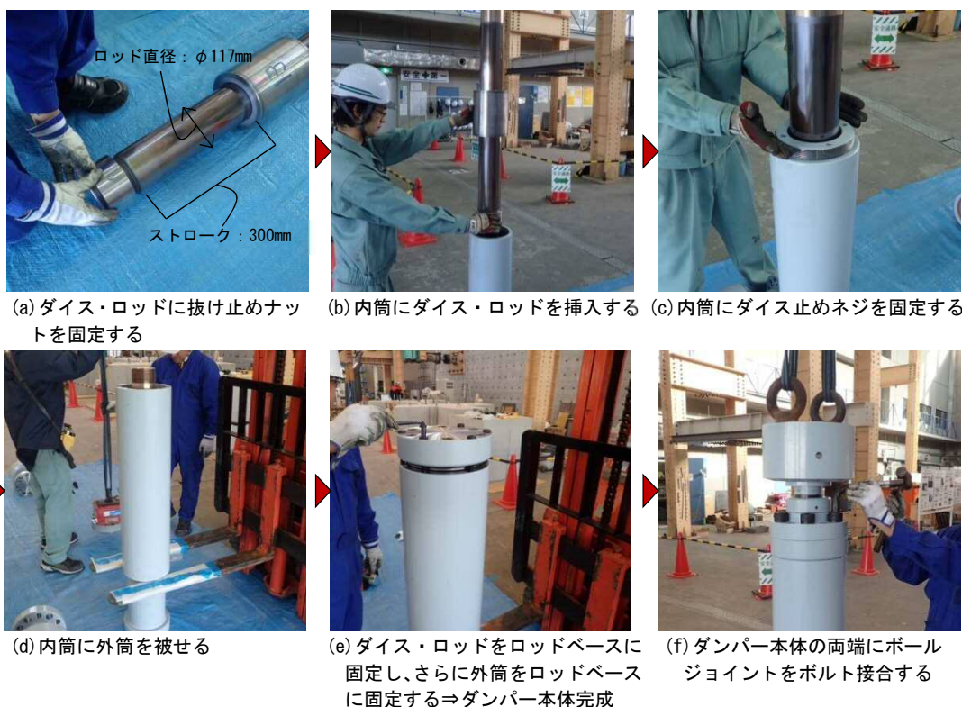
写真3 大容量摩擦ダンパーの組立て状況
