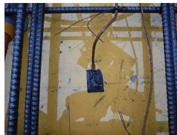
(a) 熱電対の設置
