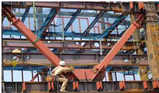
写真1 折返しブレースの建方状況
