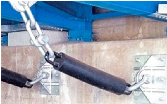
写真3 ゴム被覆チェーンによる装置の例
