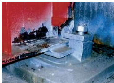
(a) 横長方形の腐食状態 3)
