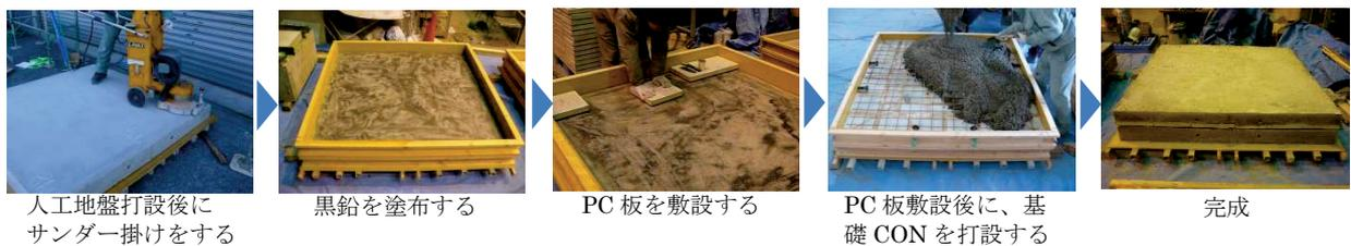
写真1 滑り基礎構法の施工概要
