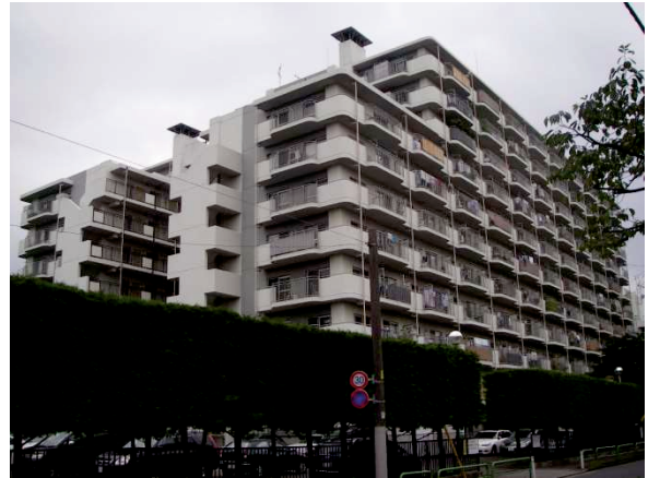
写真1 建物外観(1号棟W棟)
