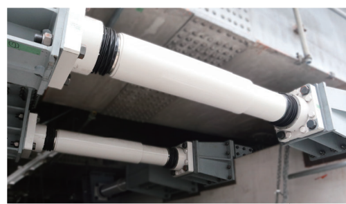
1200kN 橋軸+直角方向
