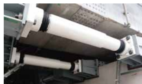
1200kN 橋軸方向+直角方向
