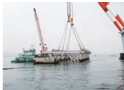
博多港(中央ふ頭地区)岸壁改良工事
