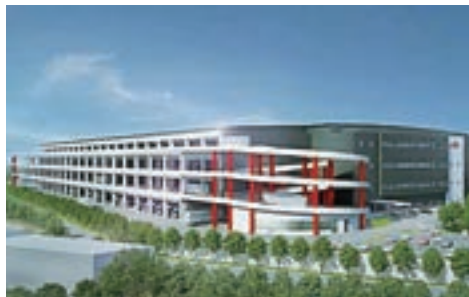
(仮称)DPL流山C棟新築工事
