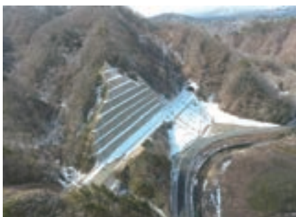
国道45号 柏木平地区トンネル工事
