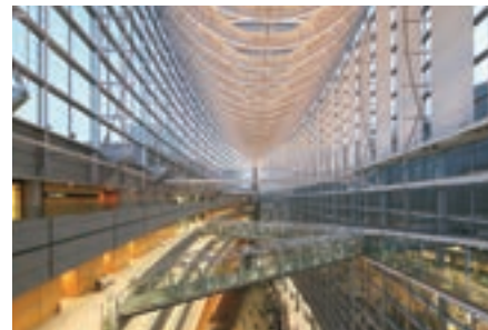
東京国際フォーラム(26)ガラス棟改修工事
