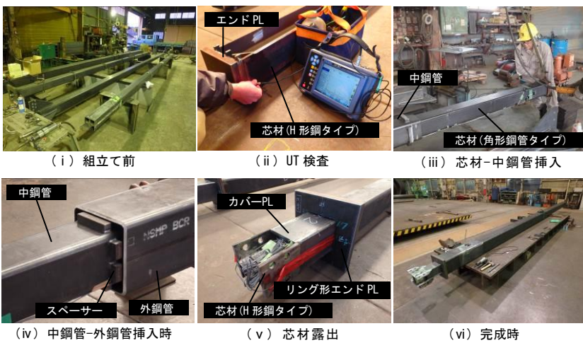
写真2 ブレース組立て状況
