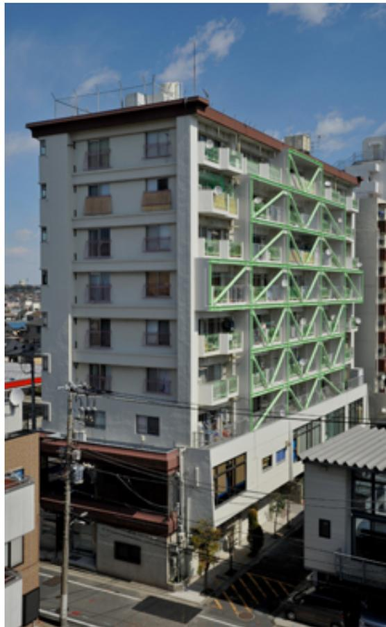
図一 1 制震ブレース取り付け図（ベランダに取り付ける場合）
