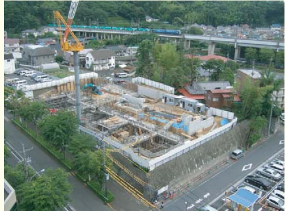
写真2: 工事現場 6月の一枚 基礎配筋施工状況
